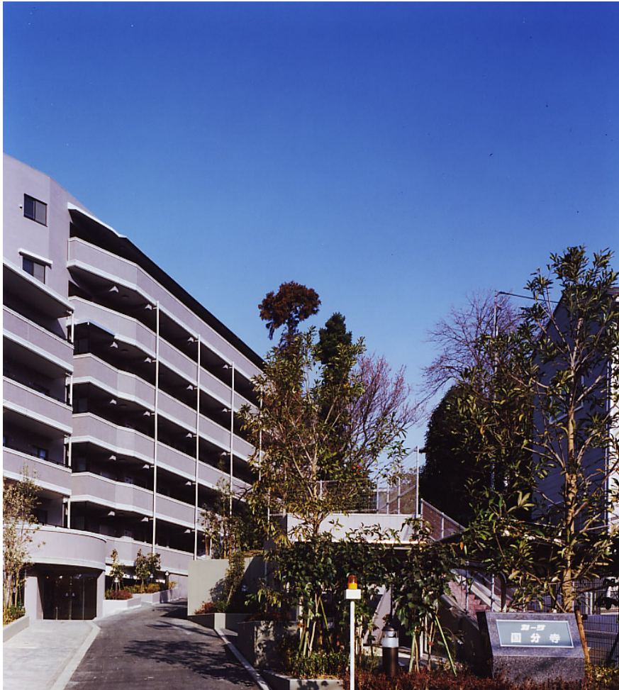
アプローチ部からの建物全景
